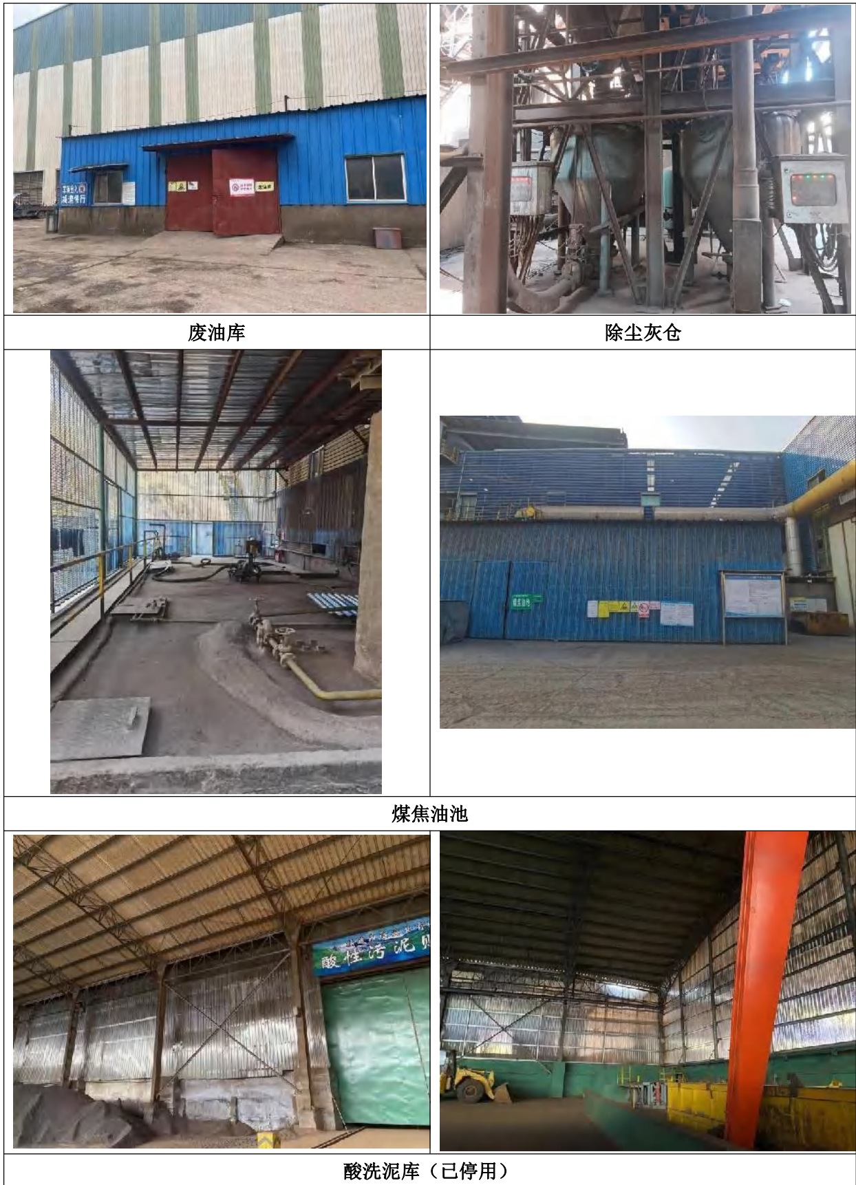
图 3.1-14 全厂危废库建设现状图
